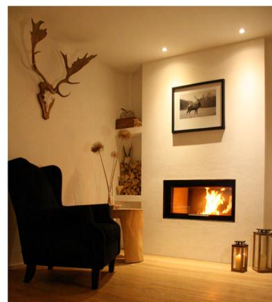
Im Winter wird über den zwischen Wohn- und Esszimmer eingebauten **Tunnelofen mit Holz** zugeheizt und die Wärme über eine Wassertasche in den Puffer transportiert. Zur Spitzenlastdeckung und bei längerer Abwesenheit wird der kurz vor dem Kauf erneuerte Heizkessel weiterverwendet.
