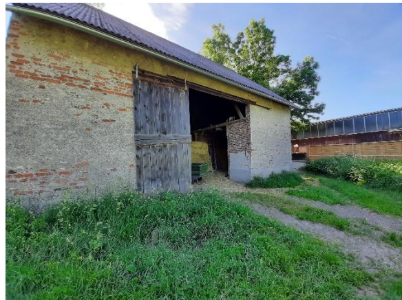
Scheune nördlich Stall/Reithalle, Foto 15.06.21
